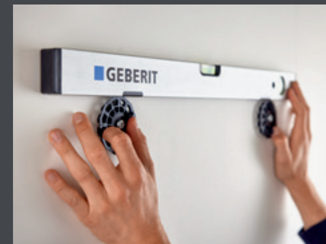
↑ Det er muligt at justere højden op til 5 mm efter spejlbeslagene er monteret.
